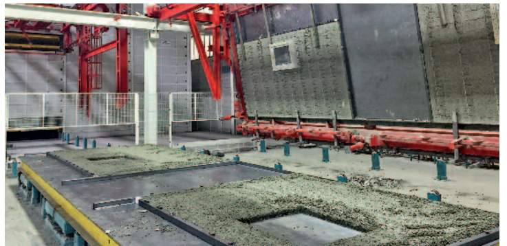
Wendestation für Doppelwandelemente
