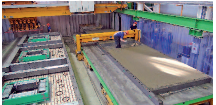
Betonieren, Verdichten, Glätten
