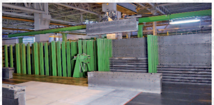
Setzen der Schalungen
